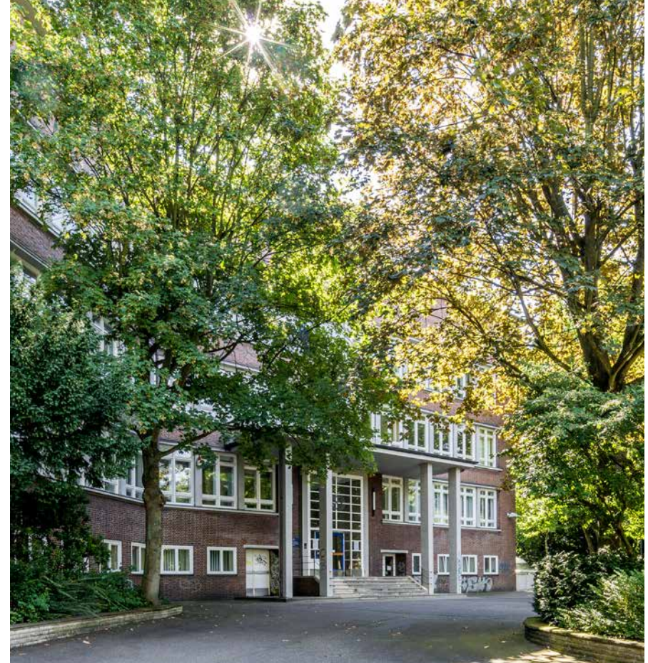
Hammer Steindamm 129, Hamburg
